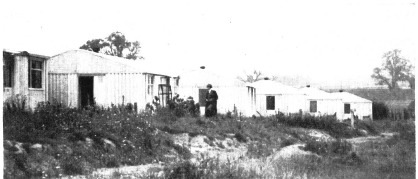
Abb. 11. Seriennotwohnungen bei Coventry aus Leichtmetall.
