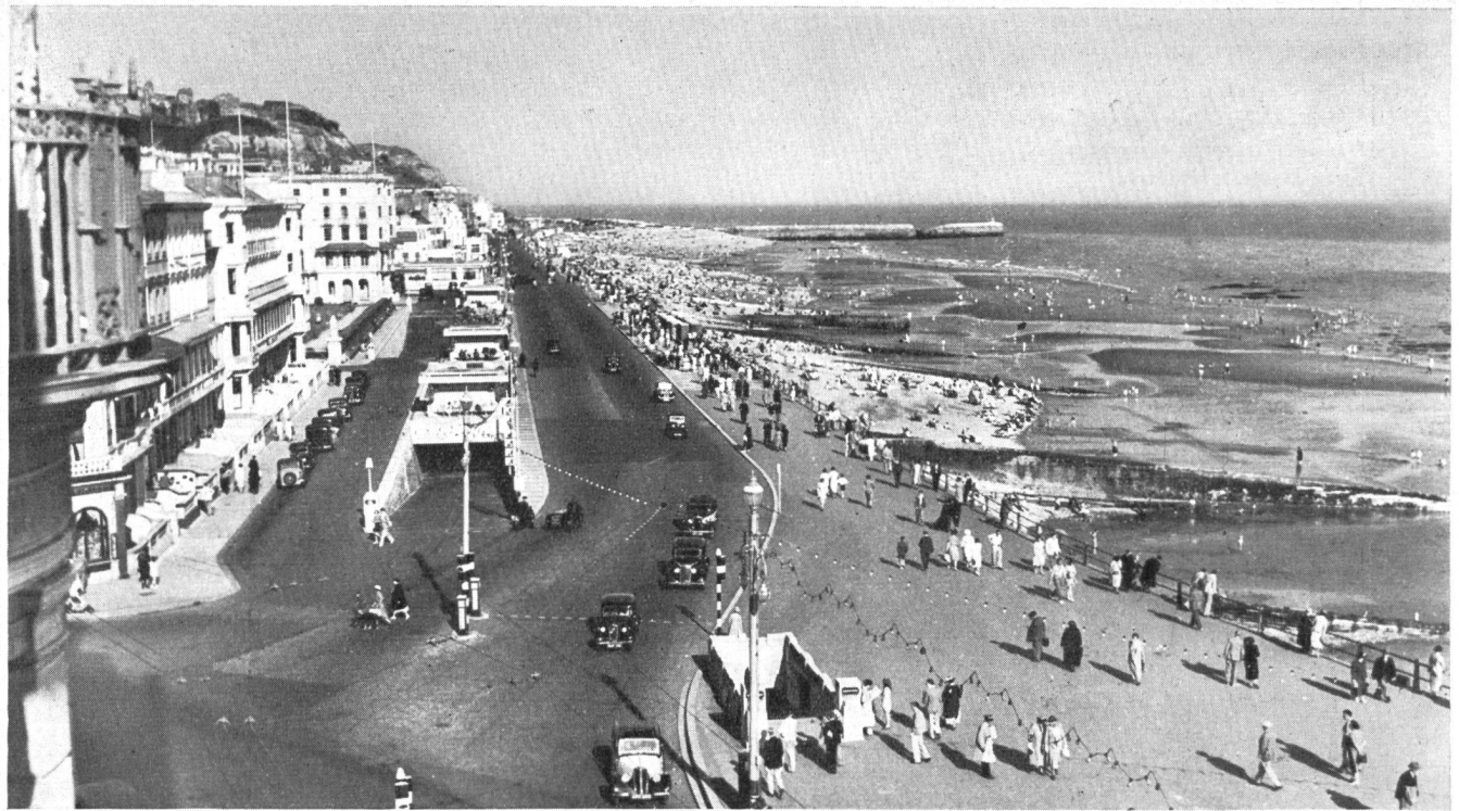
Abb. 1. Blick auf die Seepromenade von Hastings. Unter der Küstenstrasse liegt die zirka 1 km lange Parkierungsanlage für Autos. Die Rampen im Vordergrund des Bildes zeigen die Ein- und Ausgänge am Kopfe der Anlage.
