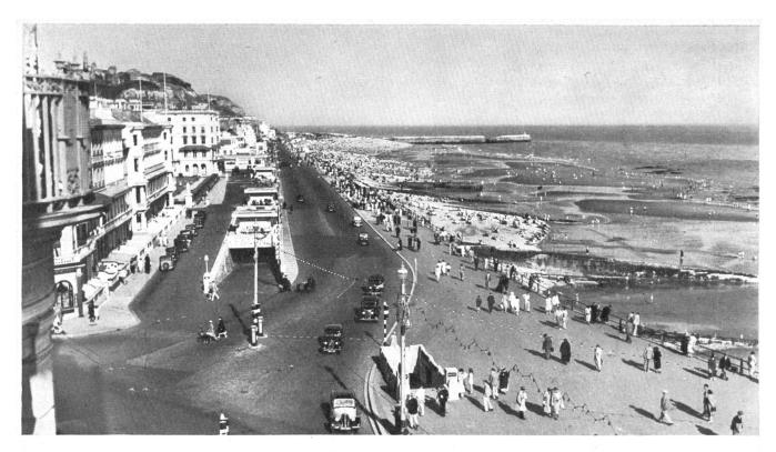
Abb. 1. Blick auf die Seepromenade von Hastings. Unter der Küstenstrasse liegt die zirka 1 km lange Parkierungsanlage für Autos. Die Rampen im Vordergrund des Bildes zeigen die Ein- und Ausgänge am Kopfe der Anlage.
