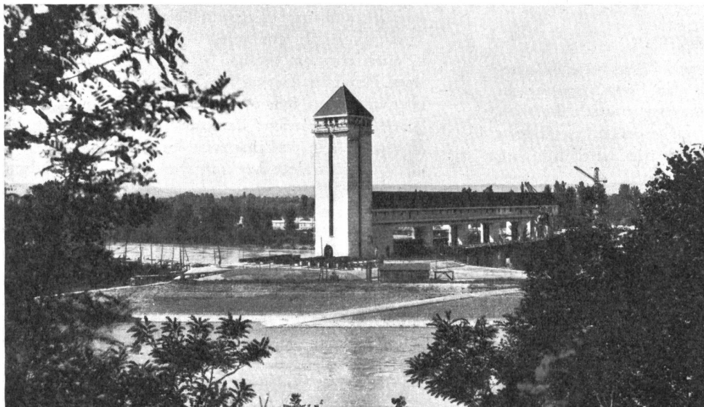
Abb. 1. Beispiel eines monumental gestalteten Stauwerkes auf der Rhone oberhalb Lyon. — Der hohe Turm hat keine technische Bedeutung und auch der als gedeckte Brücke gebaute Kontrollgang ist in dieser Form nicht notwendig.
