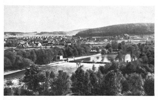
Abb. 2. Beispiel eines in die Landschaft eingefügten Stauwerkes auf der Aare bei Brugg mit bescheidenem Maschinenhaus am Ufer des Flusses. — Der Kontrollgang ist durch eine Schwebebahn mit Drahtseilaufhängung ersetzt und ist praktisch unsichtbar.
