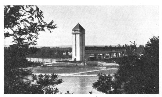
Abb. 1. Beispiel eines monumental gestalteten Stauwerkes auf der Rhone oberhalb Lyon. — Der hohe Turm hat keine technische Bedeutung und auch der als gedeckte Brücke gebaute Kontrollgang ist in dieser Form nicht notwendig.
