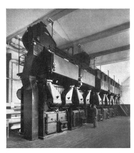
Abb. 1. Sulzer-Taschenkessel für Raumheizung und Wasserversorgung. (A. G. J. J. Rieter & Co., Töss.)
