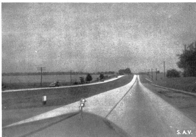
Abb. 7. Immer mehr bevorzugt man in den USA. die Anlage getrennter Fahrbahnen für die beiden Verkehrsrichtungen.
