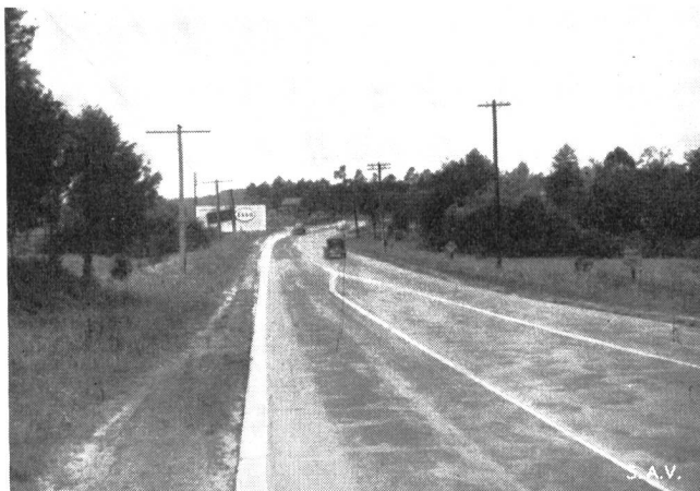
Abb. 5. Bei dieser dreispurigen Strasse ist die mittlere Spur in der Kurve unterdrückt und damit angezeigt, dass das Ueberholen untersagt ist.
