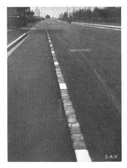
Abb. 3. Trennung des Radstreifens von der Fahrbahn durch eine Linie aus weissen "Brodtbecksteinen" und roten Pflastersteinen.
