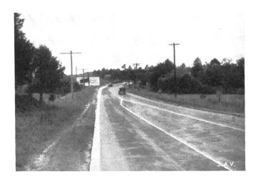
Abb. 6. Zweimal fünfspurige Strasse bei Detroit. Gesamtbreite etwa  $62~\mathrm{m}.$
