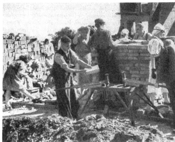
Abb. 2. Die Backsteine werden von Mörtel gereinigt.
