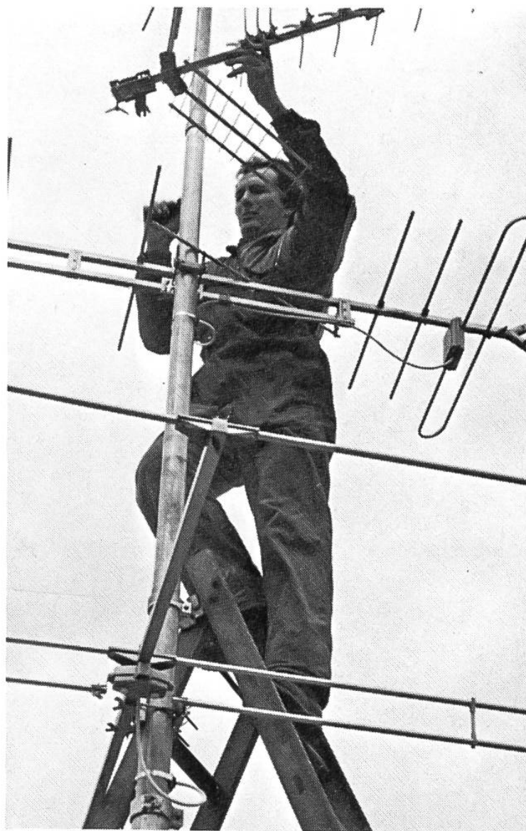
Der Fernseh- und Radioelektriker bei der Montage einer Aussenantenne.
