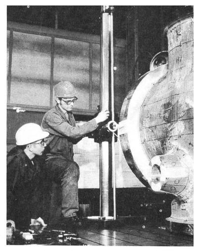
In der Kontrolle wird das Gussstück auf die Richtigkeit der vorgeschriebenen Masse kontrolliert und angerissen.
