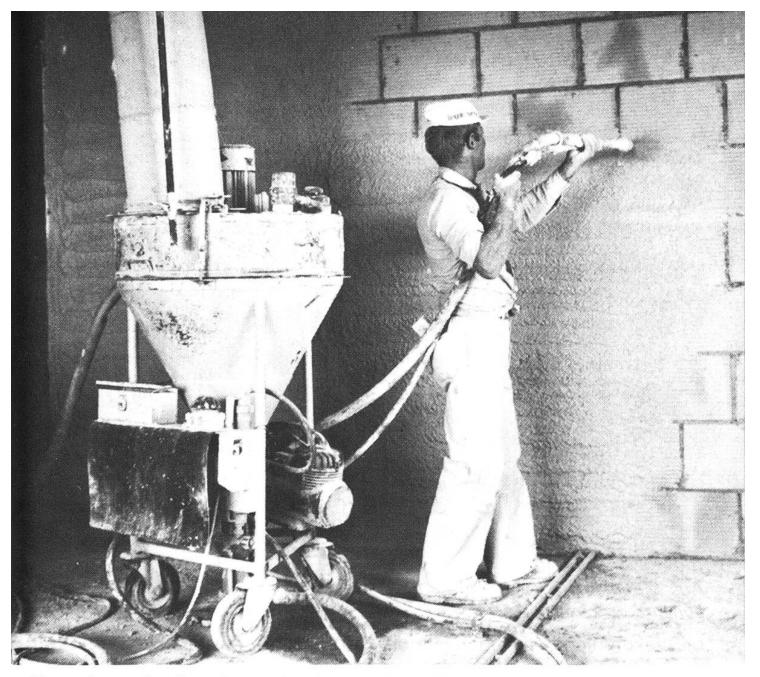
Heute kann der Grundputz oft mit einer Maschine an die Wand gespritzt und anschliessend mit einer Latte gleichmässig verteilt werden.
