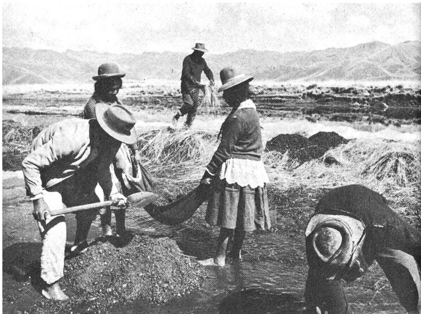
Aus dem Flussbett wird Kies geschaufelt, das mittels des Ichu-Strohes zu einem länglichem Gebilde verpackt wird.
