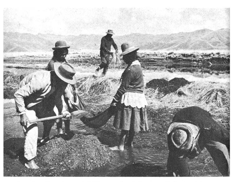
Aus dem Flussbett wird Kies geschaufelt, das mittels des Ichu-Strohes zu einem länglichem Gebilde verpackt wird.
