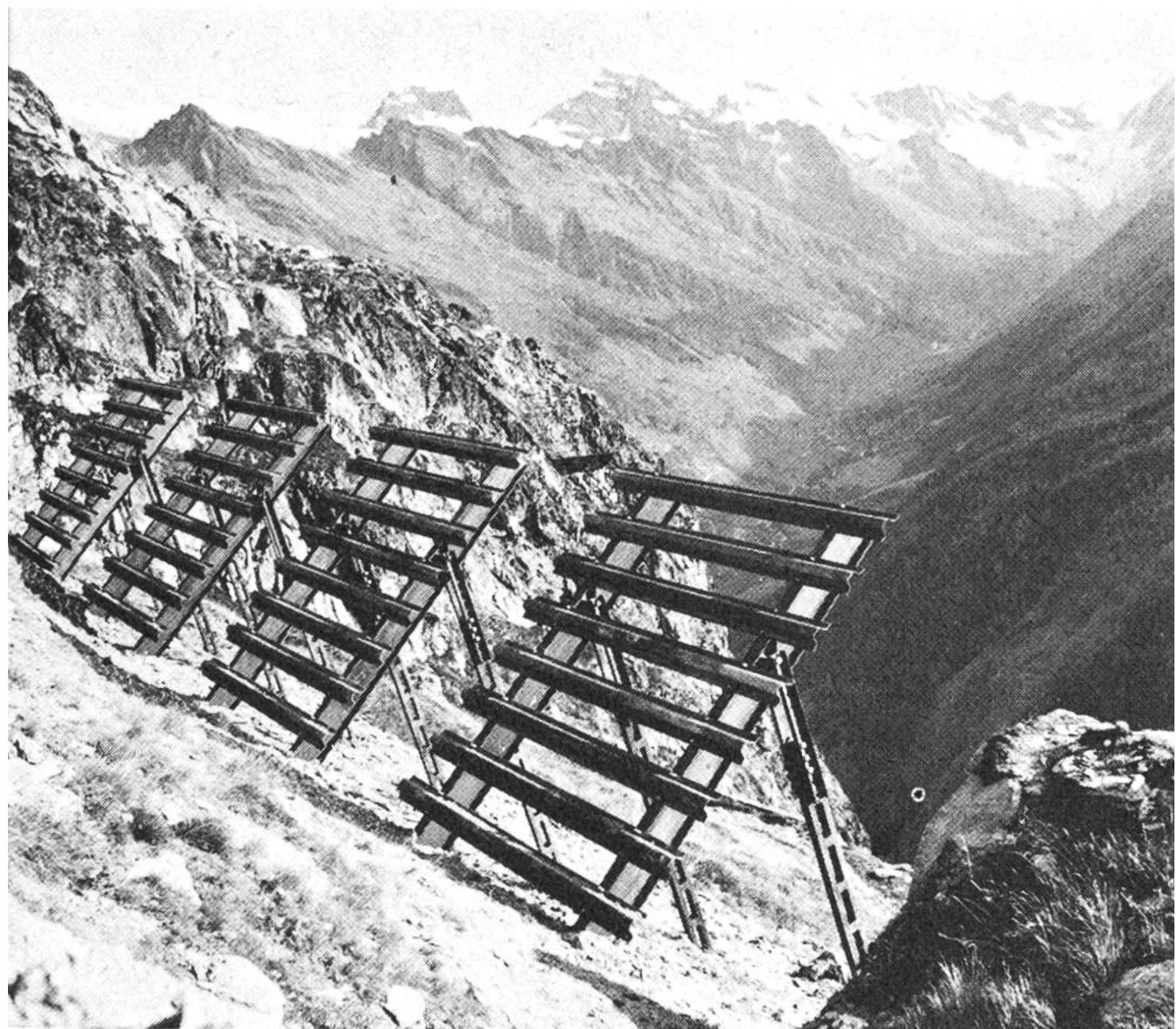
*Auf der Faldumalp. Blick in das Lötschental mit dem Langgletscher im Hintergrund. Im Vordergrund sehen wir die neuen Schneebücken aus Leichtmetall. Es brauchte manchen Schweißtropfen, um diese schweren Schienen auf 2300 m Höhe zu bringen. Mit solchen Stahlbrücken ist heute der ganze Steilhang gesichert.*
