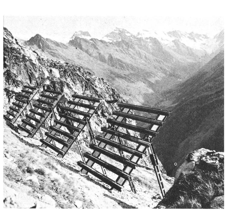
Auf der Faldumalp. Blick in das Lötschental mit dem Langgletscher im Hintergrund. Im Vordergrund sehen wir die neuen Schneebrücken aus Leichtmetall. Es brauchte manchen Schweisstropfen, um diese schweren Schienen auf 2300 m Höhe zu bringen. Mit solchen Stahlbrücken ist heute der ganze Steilhang gesichert.
