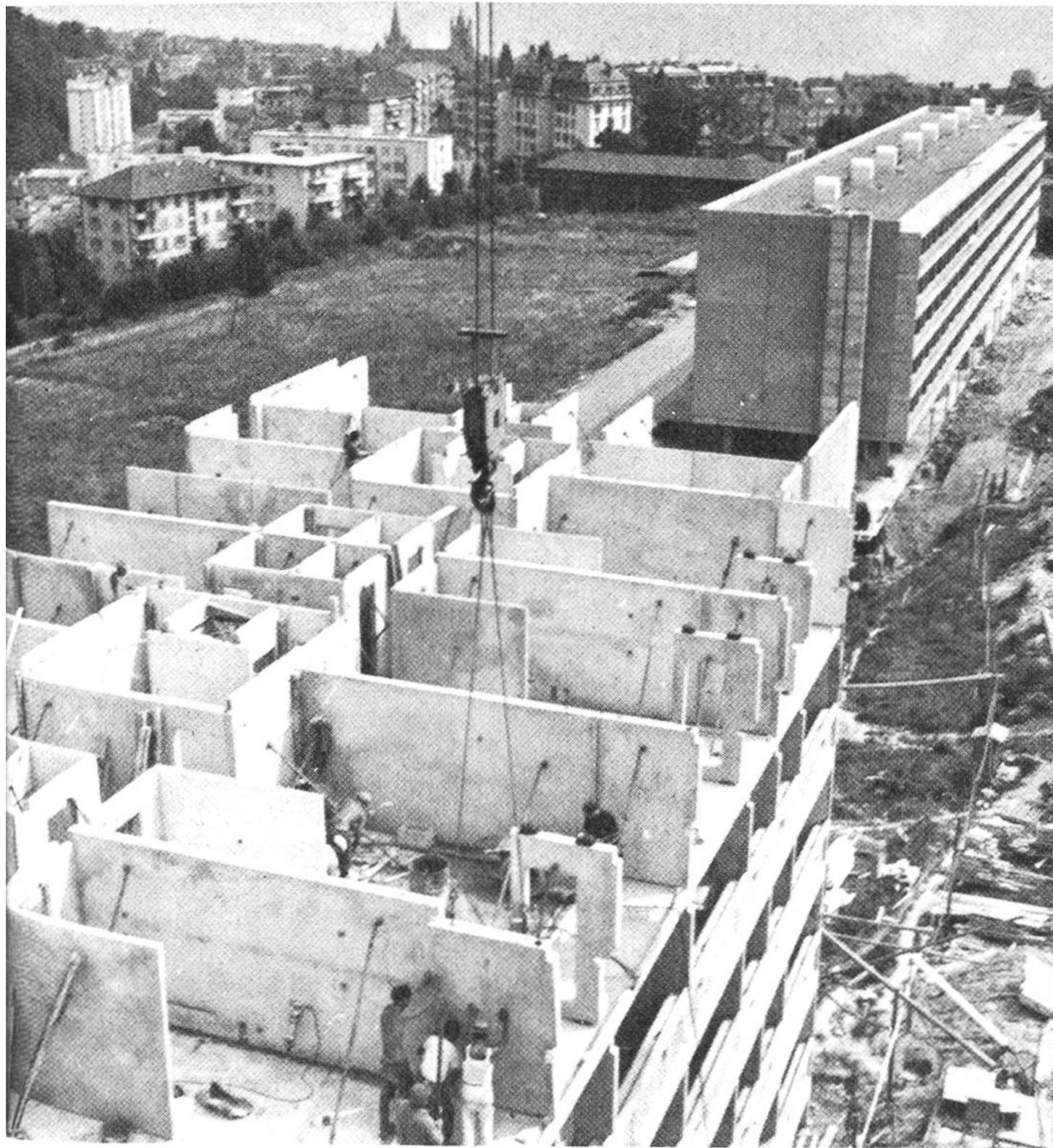
Versetzen und Richten der Wände
