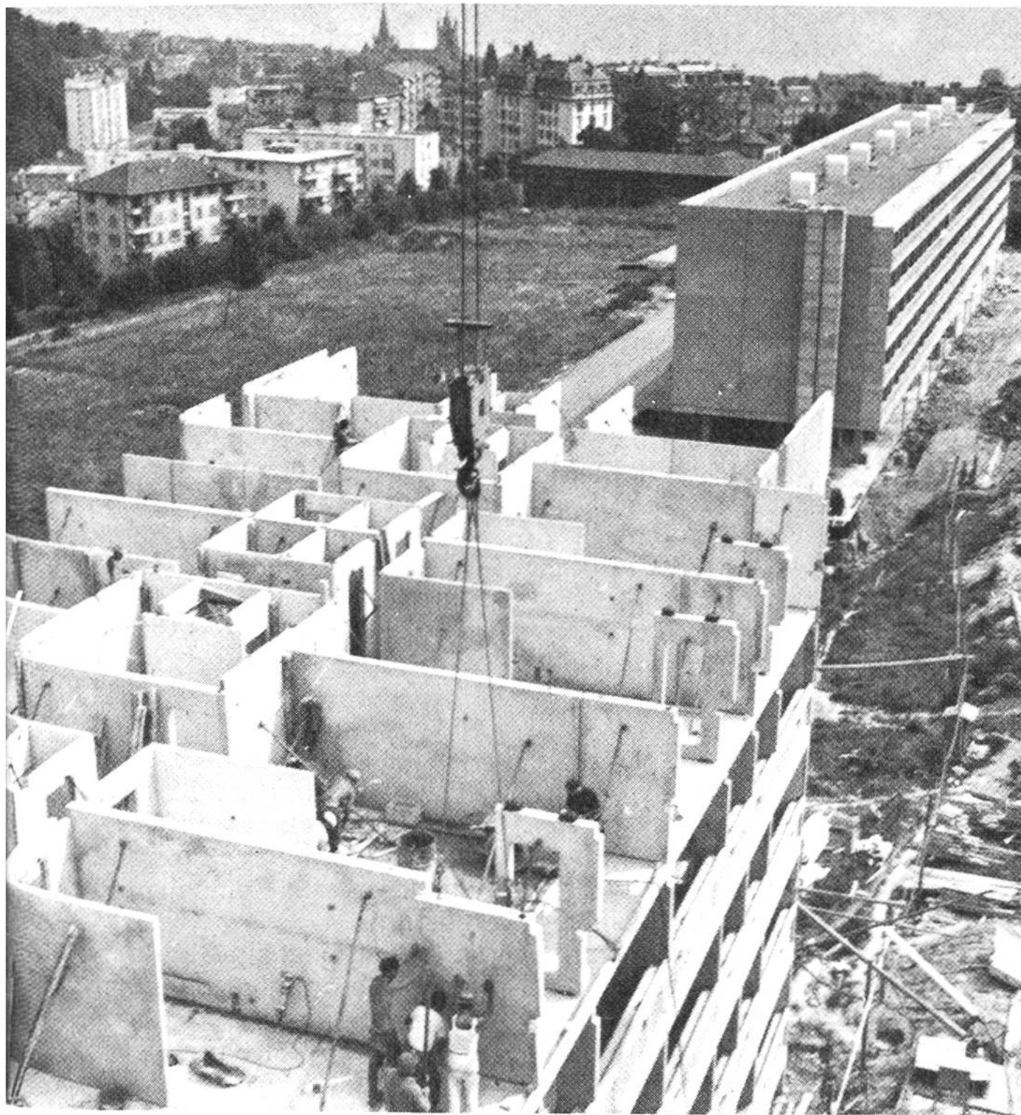
Versetzen und Richten der Wände
