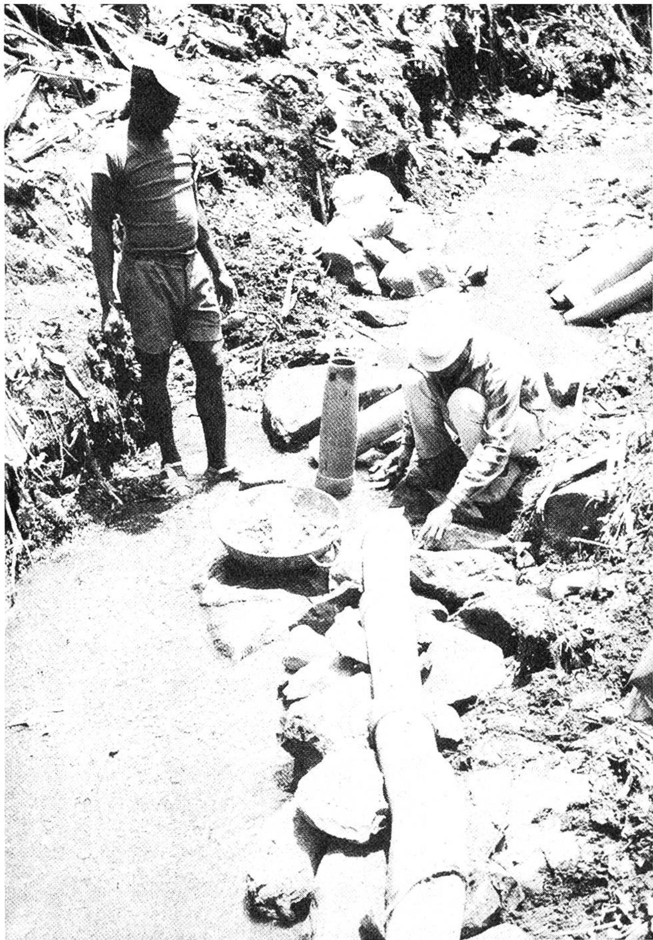
Mit der technischen und finanziellen Unterstützung von Helvetas entsteht eine Dorfwasserversorgung. Einheimische Maurer verlegen unter Anleitung des Schweizer Technikers Wassersickerröhren.
