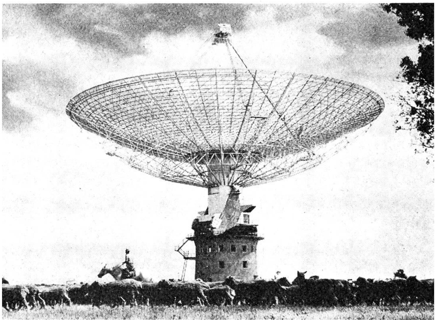
Das Parkes-Radioteleskop in Australien, gegenwärtig das grösste der Erde, hat die Höhe eines achtzehnstöckigen Hauses. Hauptteil der Anlage ist die parabelförmige Antenne, die einen Durchmesser von 64 Meter aufweist.
