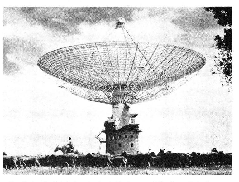
Das Parkes-Radioteleskop in Australien, gegenwärtig das grösste der Erde, hat die Höhe eines achtzehnstöckigen Hauses. Hauptteil der Anlage ist die parabelförmige Antenne, die einen Durchmesser von 64 Meter aufweist.
