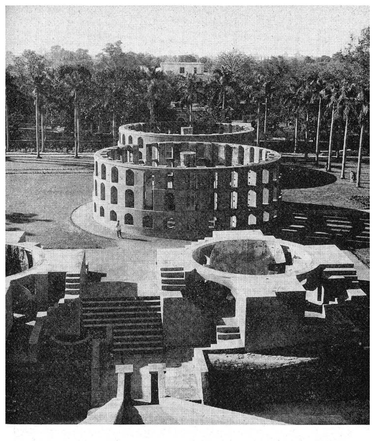
Welch gewaltige Arbeit musste aufgewendet werden, um diese schalenförmigen Platten zu schleifen und zu gravieren! Von oben gesehen erscheint der darunterliegende Kellerraum ganz schwarz. Hier standen die Beobachter und visierten durch die Schlitze die Gestirne an. Zwei über die Halbkugel gespannte
