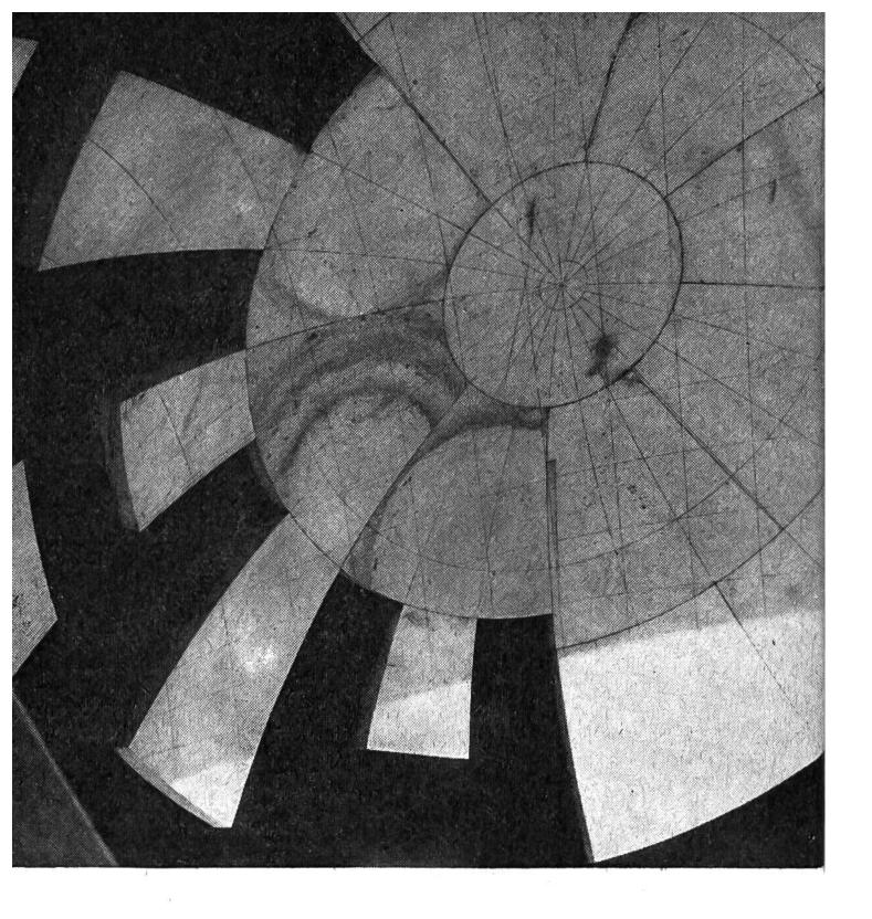
Drähte markierten dabei als Fixpunkt die Kugelmitte. Auf diese Weise konnte die Deklination der Gestirne an der Gravierung der Marmorplatten abgelesen werden.
