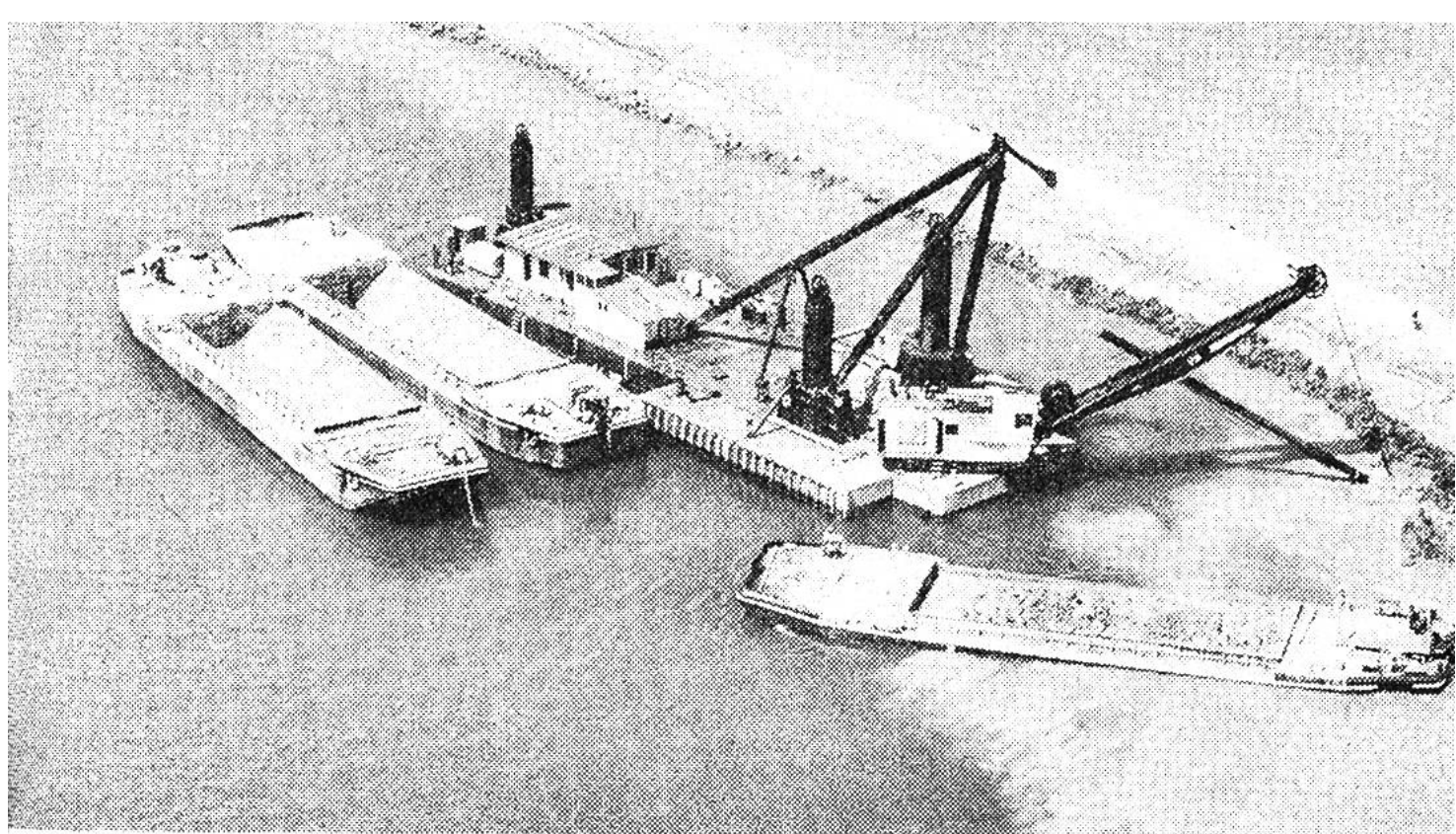
Der grosse amerikanische Schwimmbagger beim Verbreitern des Nidau-Büren-Kanals mit drei Klappschiffen zu je 500 Tonnen.
