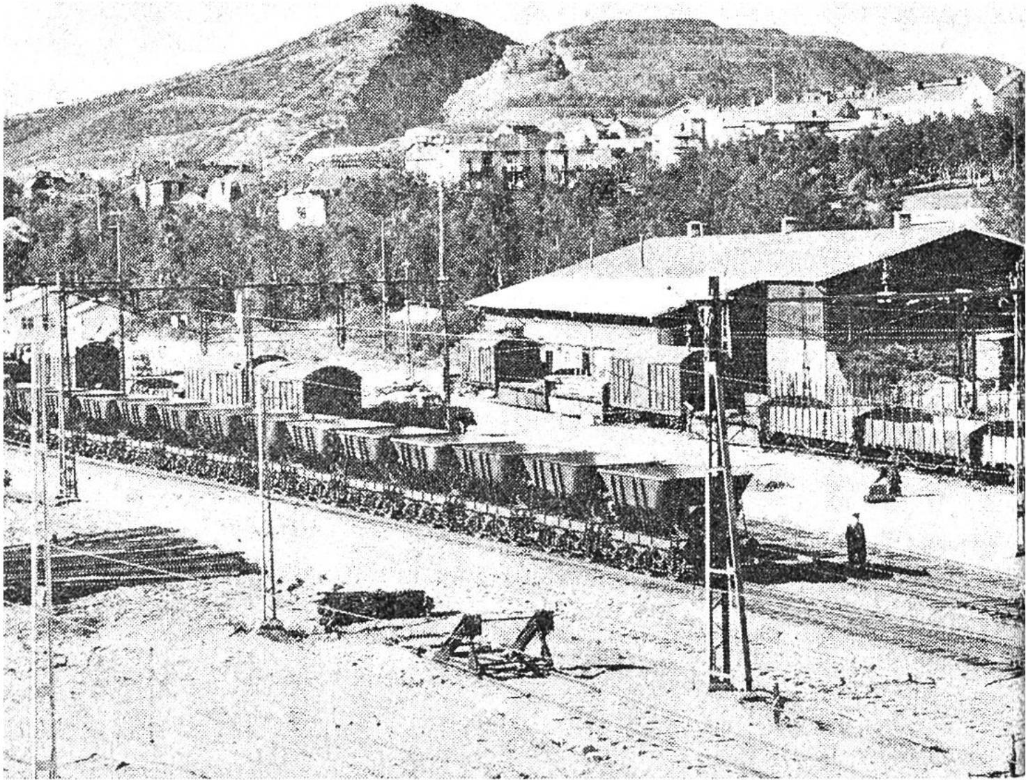
Im Güterbahnhof von Kiruna bestimmen die Spezialwagen für den Erztransport das Bild. Im Hintergrund der mitten aufgespaltene Luossavaara (ausgeräumt, in die Tiefe tauchende Erzschicht) mit dem rechts terrassenförmig aufgeschütteten Abraumgestein.
