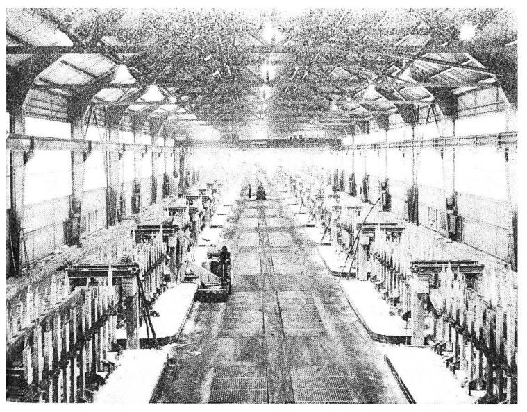
In der Ofenhalle der Aluminiumhütte wird aus der Tonerde durch Elektrolyse das reine Aluminium gewonnen. In Reih und Glied stehen die Elektroöfen den Wänden entlang. Man erkennt die Elektroden (Anoden), die immer tiefer in die Schmelzmasse eingesenkt werden müssen, weil sie allmählich verbrennen.
