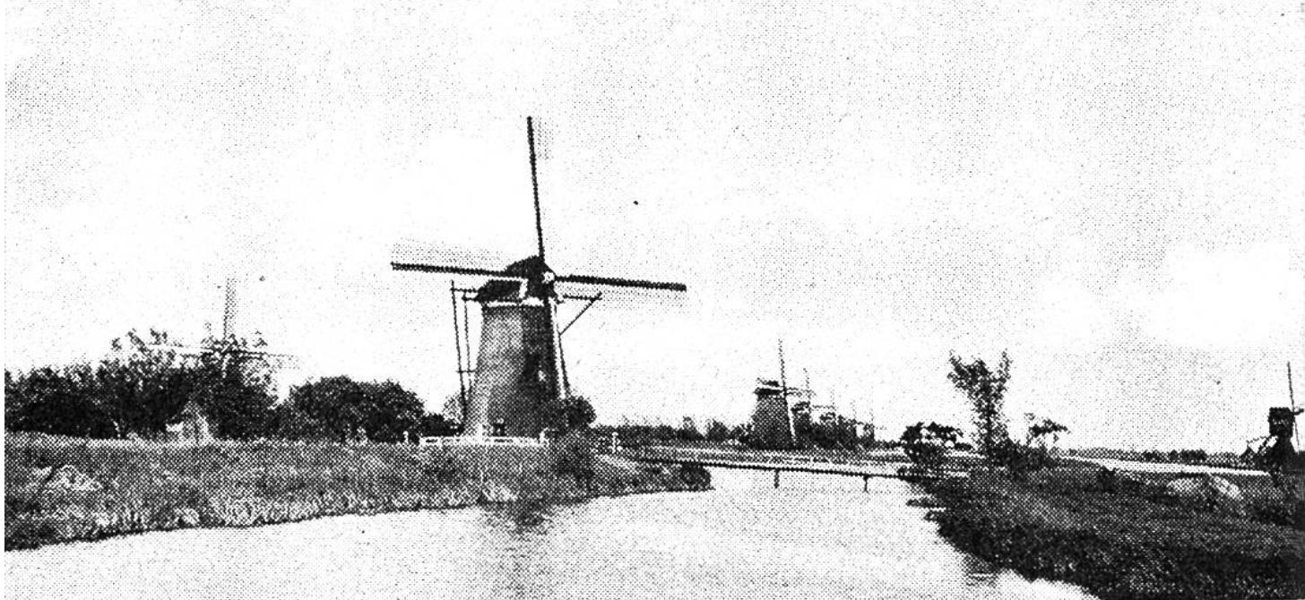
Längs der lebenswichtigen Entwässerungskanäle stehen oft ganze Reihen von unermüdlich tätigen Windmühlen, welche die Entwässerung bewerkstelligen. Im Hintergrund rechts eine alte Bockmühle mit drehbarem Haus.
