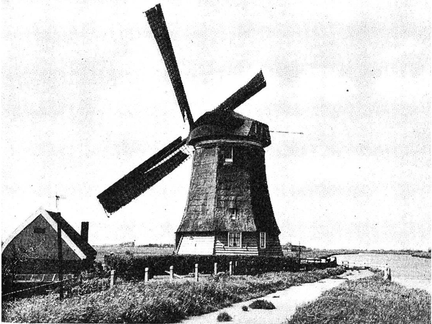
Die Windmühle ist vollständig verwachsen mit der holländischen Polderlandschaft. Ihre Aufgabe ist es, das überschüssige Grundwasser aus dem tiefer als der Meeresspiegel liegenden Land links in den Entwässerungs-kanal rechts zu pumpen.
