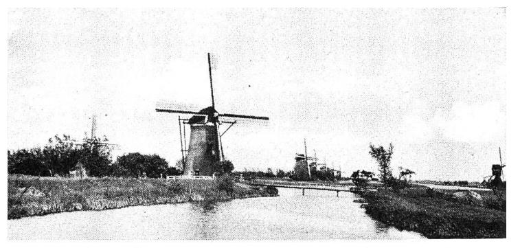
Längs der lebenswichtigen Entwässerungskanäle stehen oft ganze Reihen von unermüdlich tätigen Windmühlen, welche die Entwässerung bewerkstelligen. Im Hintergrund rechts eine alte Bockmühle mit drehbarem Haus.
