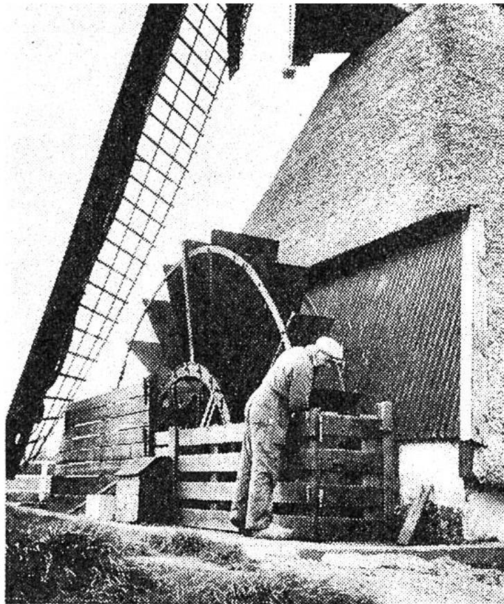
eine gürtelähnliche Plattform. Auf dieser stehend, können die starken Müllerburschen die Stangen ergreifen und den Propeller in den Wind drehen. Von der rotierenden, waagrecht gelagerten Flügelwelle wird die Kraft durch Zahnradübersetzungen auf das Mühlenwerk übertragen, die Getreidemühle, die Säge oder die Pumpen.
