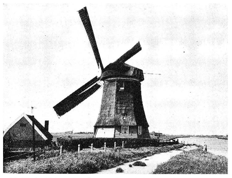
Die Windmühle ist vollständig verwachsen mit der holländischen Polderlandschaft. Ihre Aufgabe ist es, das überschüssige Grundwasser aus dem tiefer als der Meeresspiegel liegenden Land links in den Entwässerungskanal rechts zu pumpen.
