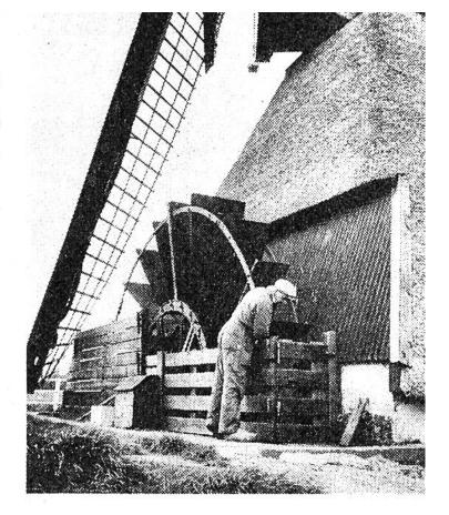
eine gürtelähnliche Plattform. Auf dieser stehend, können die starken Müllerburschen die Stangen ergreifen und den Propeller in den Wind drehen. Von der rotierenden, waagrecht gelagerten Flügelwelle wird die Kraft durch Zahnradübersetzungen auf das Mühlenwerk übertragen, die Getreidemühle, die Säge oder die Pumpen.
