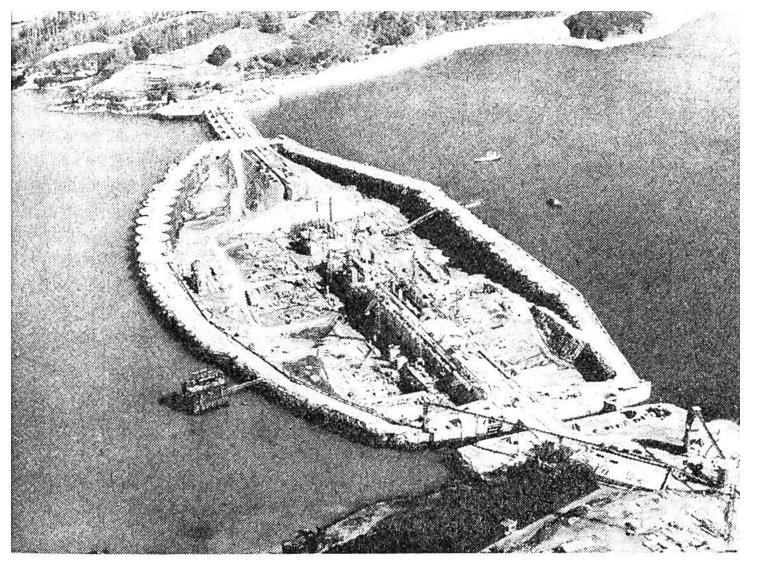
Flugaufnahme des Baues in der Bucht der Rance. Erkennbar die Staumauer, die die innere Bucht vom Meere abriegelt, die zusätzliche Mauer, die das Werkgebäude vor kräftigem Hochwasser schützen soll, und die Fundamente des Maschinentraktes.
