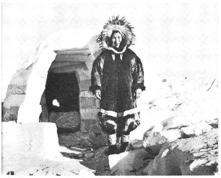
Der Baumeister vor seinem fast vollendeten Werk, dem aus Schneeblökken gefügten, kuppelförmigen Iglu.
