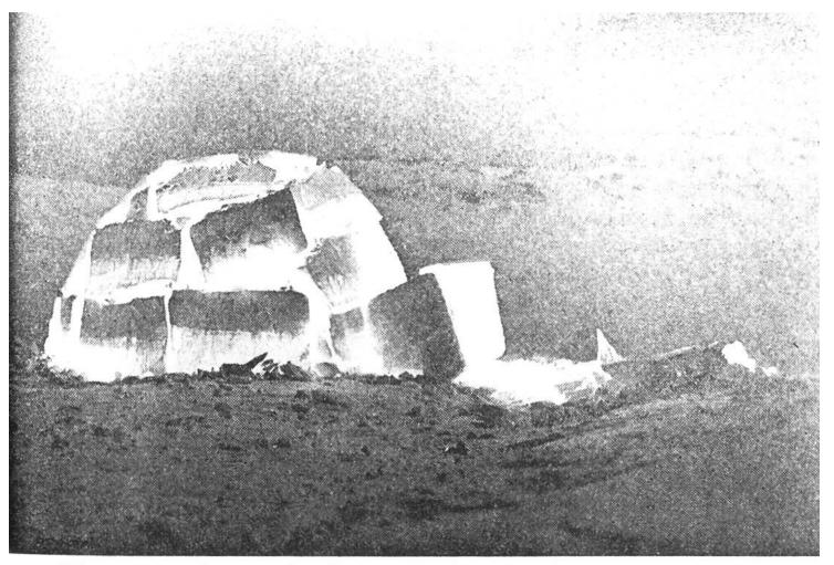
Winterzauber im amerikanischen Norden. Das durchscheinende Licht lässt die Konstruktion der Schneekuppel erkennen und hebt zugleich hervor, wie verschieden dicht der Schnee war, aus dem die Blöcke gestochen wurden.
