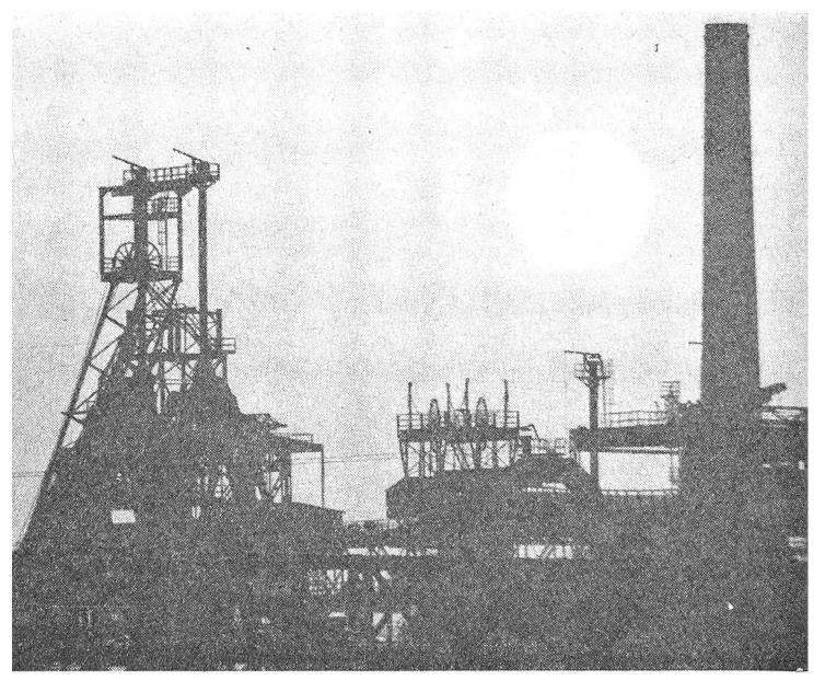
In «technischer Schönheit» präsentieren sich die über Tag sichtbaren Bauten des Kohlenbergwerkes, vor allem die turmartigen Fördergerüste über dem offenen Schacht.
