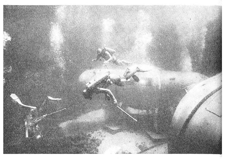
Aufbruch zu einer Unterwasserexkursion. Im Hintergrund das auf verstellbaren Stelzen ruhende Unterwasserhaus. Vorne rechts die «Garage», die das «Untertassen»-Tauchboot birgt.
