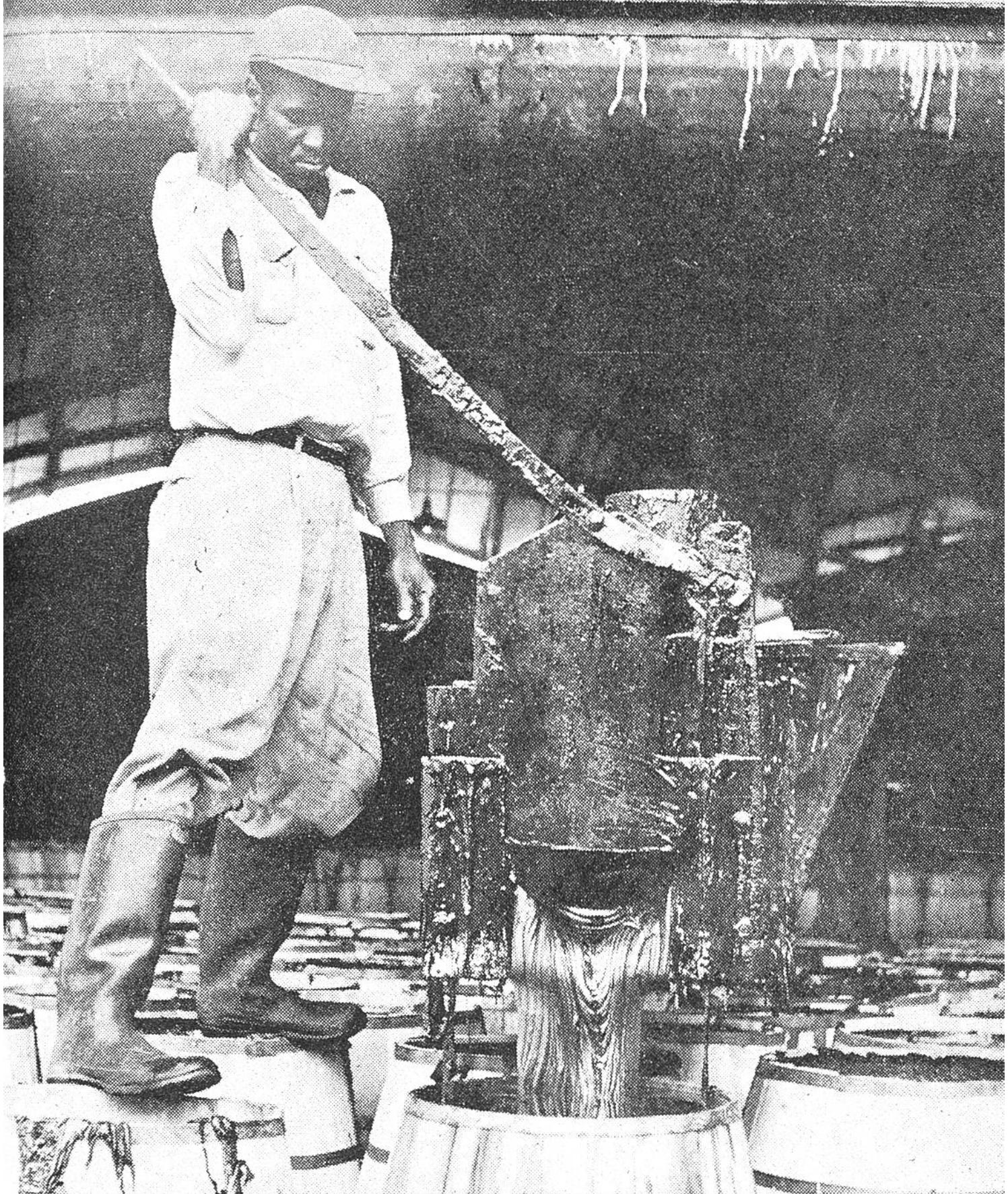
Der fertig aufbereitete Asphalt wird für den Export in Fässer abgefüllt.
