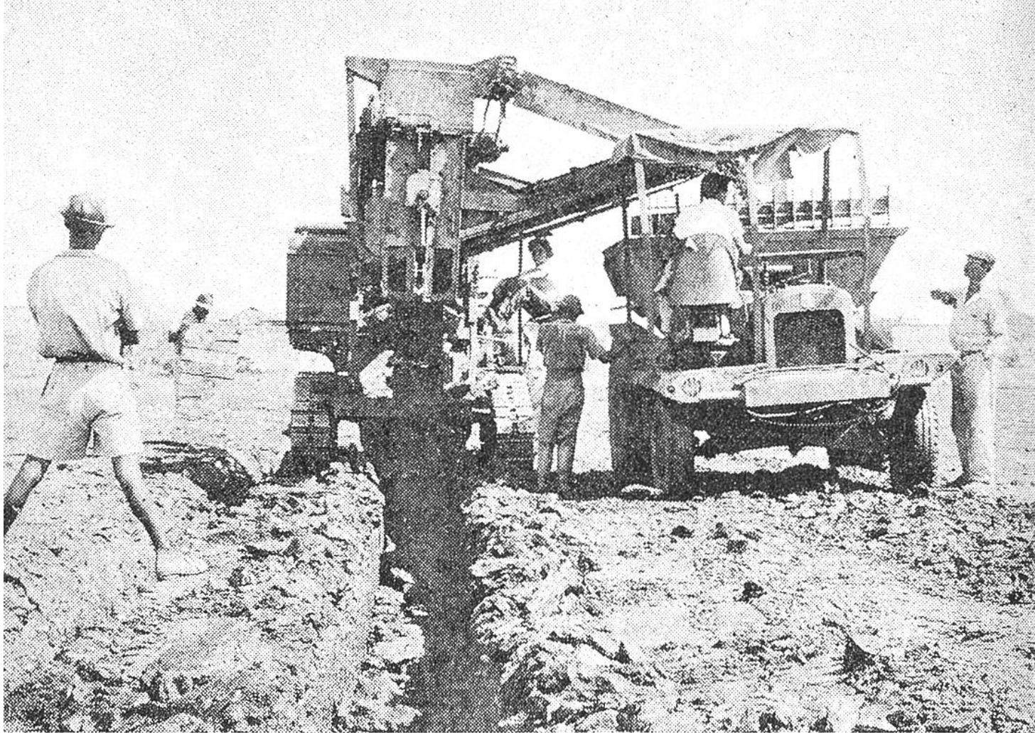
Neuerdings wird der Asphalt, mit modernen Maschinen abgestochen, in die bereitstehenden Lastwagen gekippt.
