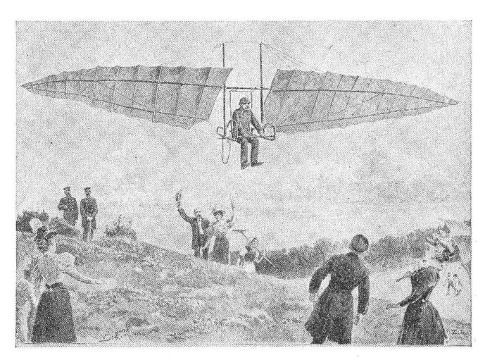
Mit weniger Erfolg als die Lilienthals beschäftigte sich der Berliner Konstrukteur Buttenstedt mit dem Bau von Gleitfliegern, mit welchen er von einer Anhöhe talwärts glitt. Die Flügel seines Apparates blieben vollkommen unbeweglich und höhlten sich auch bei Wind nicht ein. Das Bild stammt aus dem Jahre 1898.
