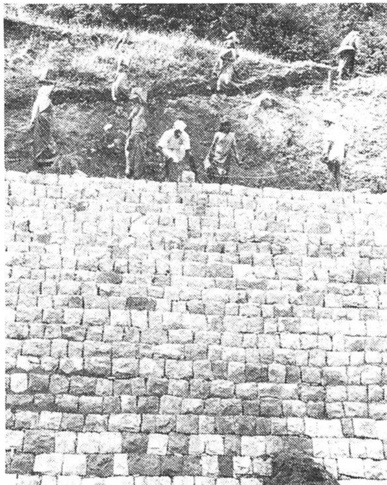
Bau einer Uferstützmauer aus lose aufeinander geschichteten Steinen. Das gesamte Material wird durch Lastträger zur Stelle geschafft.
