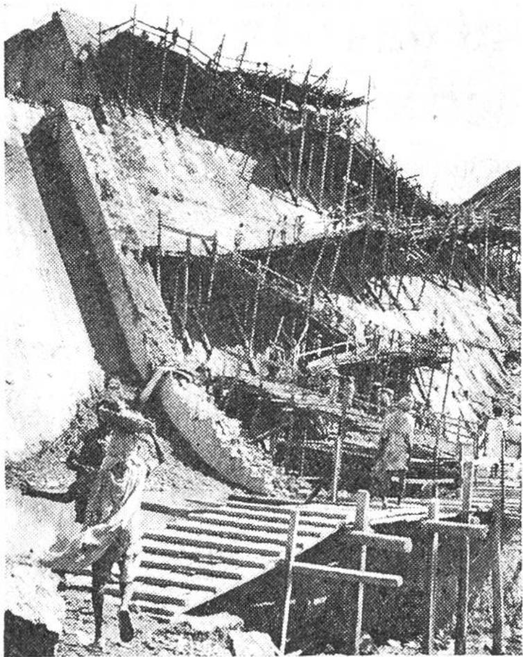
Dammbau in Indien. Alles Baumaterial wird durch Lastträger zur Mauerkrone hinauf befördert.
