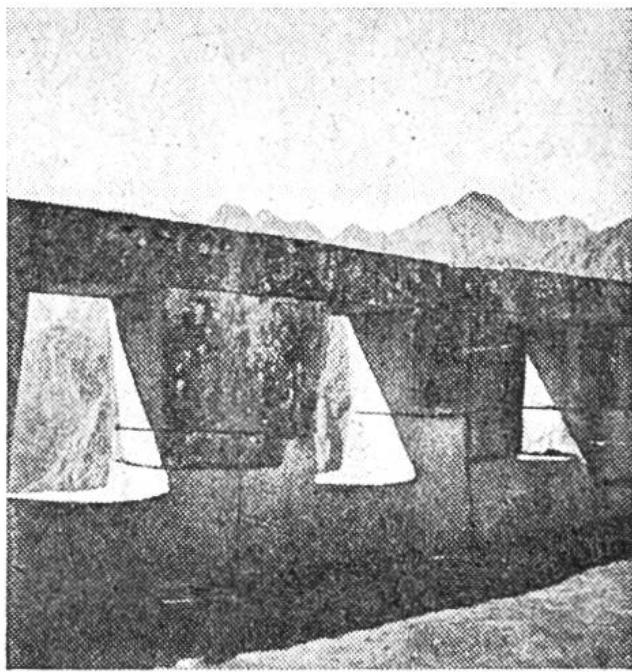
Die Mauern sind alle ohne Mörtel aus gewaltigen Granitblöcken gefügt. Türen und Fenster sind trapezförmig. Ihre Winkel entsprechen dem Spaltungswinkel des Quarzes.
