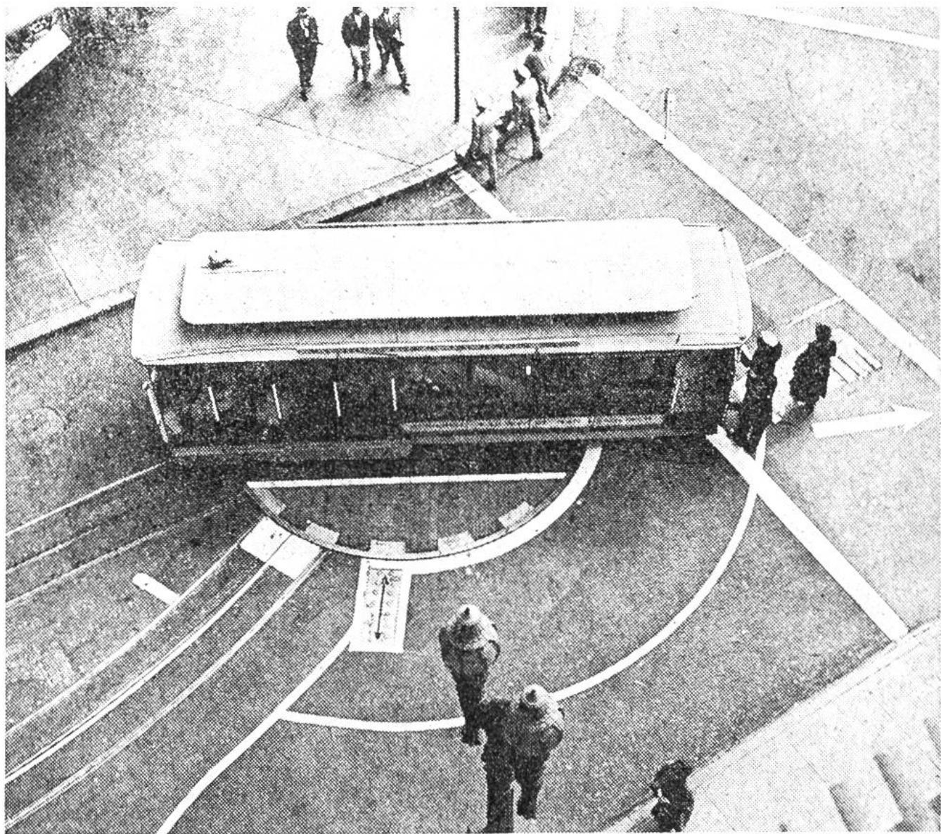
An Anfang und Ende jeder Strecke befindet sich eine Drehscheibe, auf der mit Hilfe von Passagieren oder Passanten die Wagen gedreht werden.
