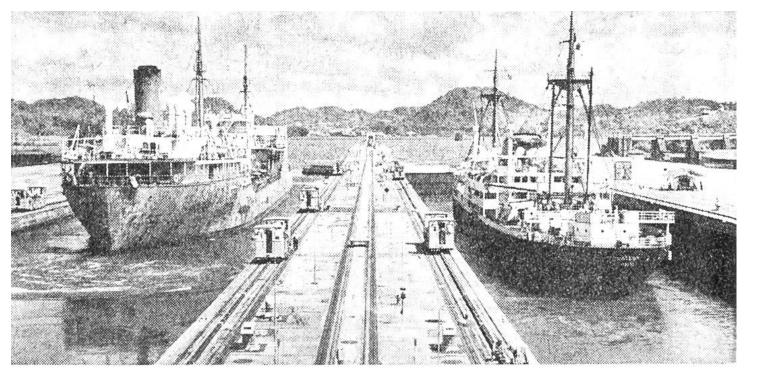
Die linke Schleuse öffnet sich eben, rechts wartet ein Schiff, bis sich der Wasserspiegel genügend gehoben hat. Die kleinen Lokomotiven, «Maulesel» genannt, manövrieren die Schiffe in den Schleusen.
