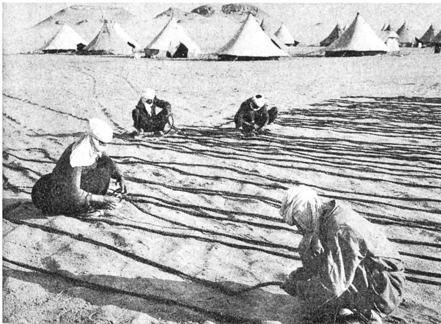
Vor dem Zeltlager eines Ölsuchtrupps bei der Oase Ouargla. Eingeborene Hilfskräfte überprüfen die langen Kabelstränge, die für die seismischen Untersuchungen benötigt werden.
