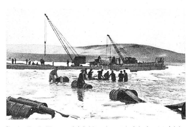
Resolute Bay. Im Hintergrund ein Leichter, der zum Ausladen benutzt wird; im Vordergrund die zum Weiterleiten des Dieselöles bestimmte Schlauchleitung.
