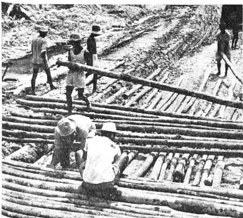
Legen des Rostes aus Baumstämmen.
