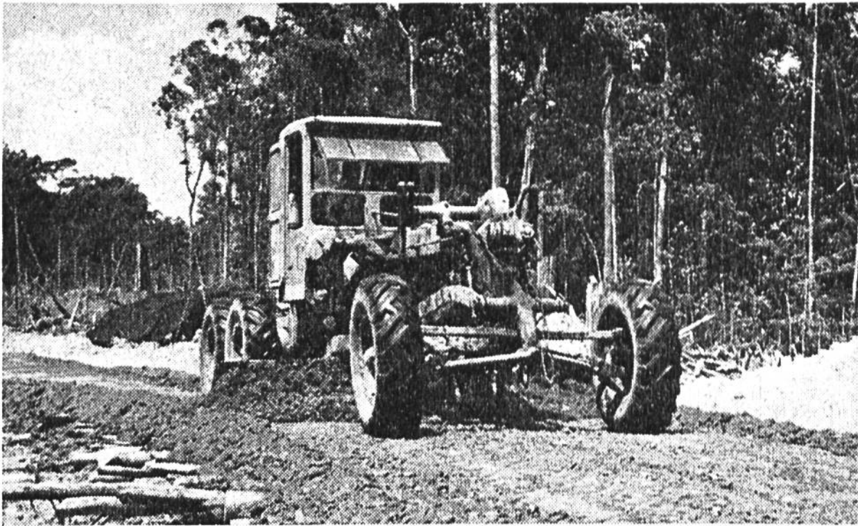
Überdecken des Rostes mit Erde und mechanisches Ausebnen.
