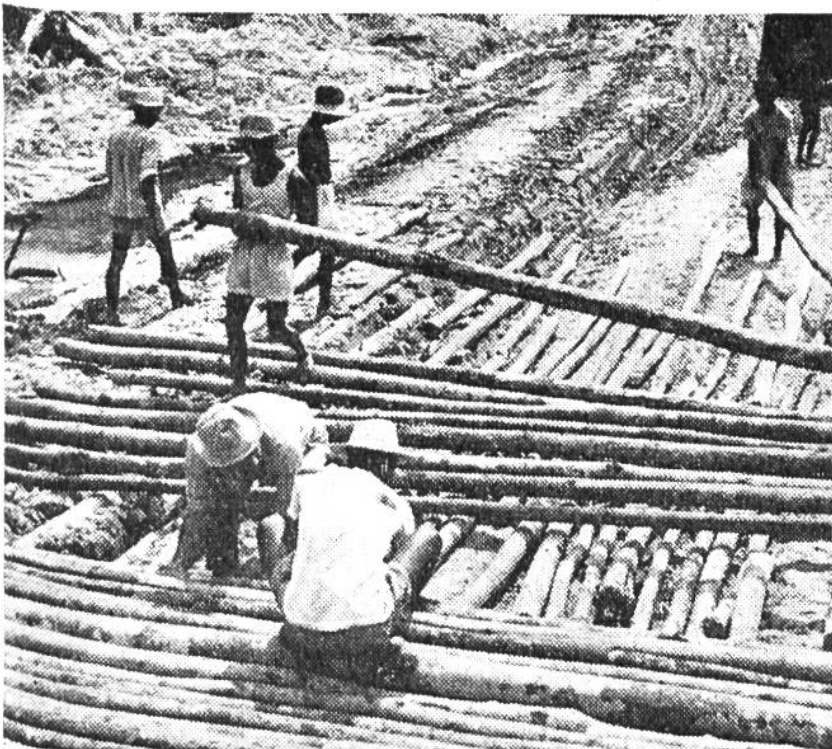
Legen des Rostes aus Baumstämmen.
