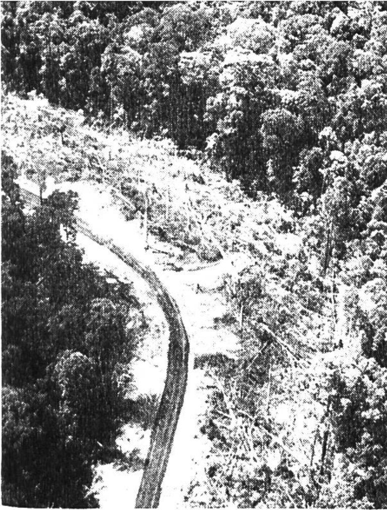
Die fertige Strasse im Urwald von Sumatra.
