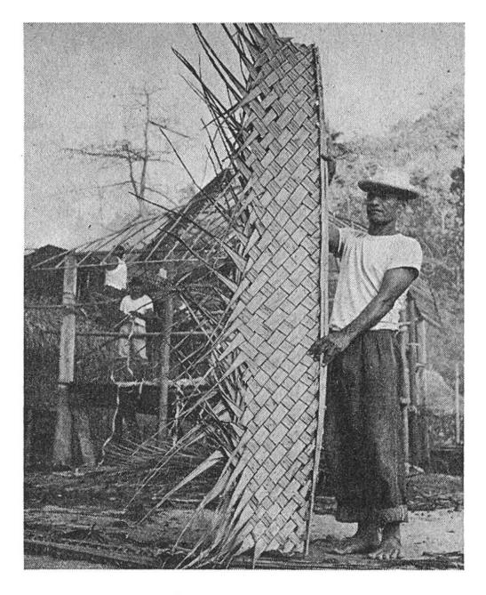
So sieht eine fertig geflochtene Matte aus, die auf das Dach gelegt werden soll. Man lässt die Enden der einzelnen Blatteile unregelmässig herausstehen, da sie mithelfen, das Wasser abzuleiten.
