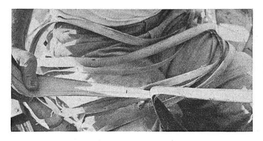
Zu den vorbereitenden Arbeiten eines Hausbaues gehört daher das Zerlegen geeigneter Rindenarten in lange, gerade, ebenso schmiegsame wie feste Streifen oder Gurten.
