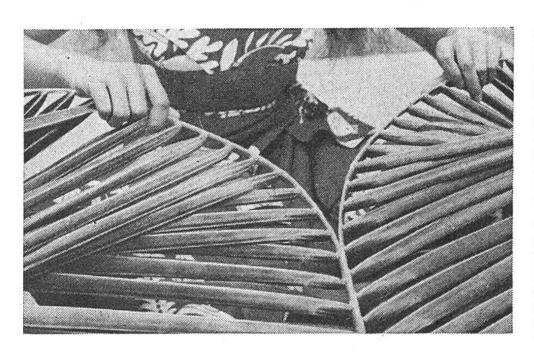
Zum Decken des Daches verwendet man aus Palmwedeln geflochtene Matten, Man spaltet zuerst die Mittelrippe des Wedels und verflicht dann die Blatteile je einer Seite miteinander zu den Matten.
