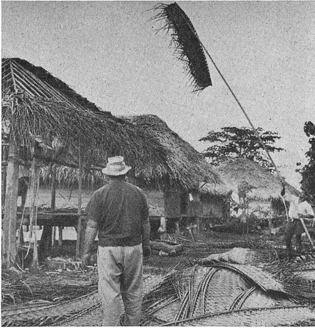
An einem langen Stab werden den Bauleuten die Matten hinaufgereicht.
