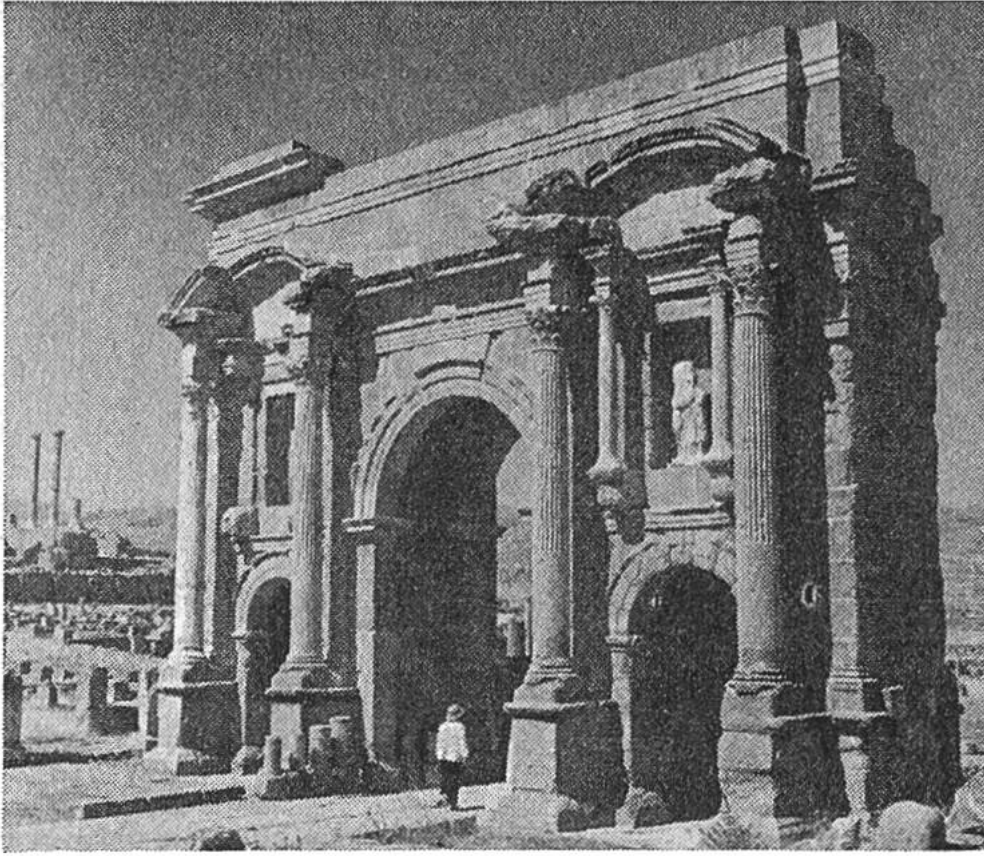
Das Westtor. Durch die 3,5 m breite mittlere Öffnung ging der Wagenverkehr; die beiden seitlichen Durchgänge dienten den Fussgängern.
