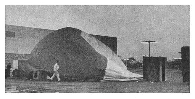
Wenn die Vorführungen im Astrotarium beendet sind, wird die Druckluft herausgelassen. Die Zeltkuppel sinkt zusammen und lässt sich leicht an einen anderen Ort transportieren.
