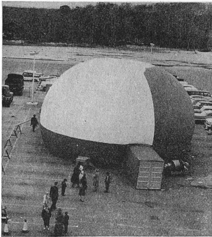
Die Kuppel des Astrotariums, wie das amerikanische Wander-Planatorium genannt wird, besteht aus einem Zelt, das mit Druckluft kugelförmig aufgeblasen wird.
