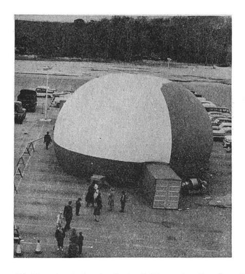
Die Kuppel des Astrotariums, wie das amerikanische Wander-Planetarium genannt wird, besteht aus einem Zelt, das mit Druckluft kugelförmig aufgeblasen wird.
