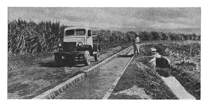
Zuckerrohr benötigt zu seiner Entwicklung viel Wasser. Mit Hilfe von grossen Bewässerungsanlagen können wertlose, trockene Gebiete jetzt auch für die Zuckerrohrkultur nutzbar gemacht werden. Das Bild zeigt einen grossen Bewässerungskanal mit einer Abzweigung, die in das Feld führt. Die Versorgung des Seitenarmes mit Wasser wird durch Öffnen und Schliessen eines Schleusentores seitlich am grossen Kanal geregelt.
