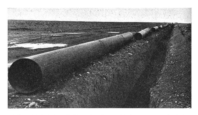
Die riesigen nahtlosen Stahlrohre werden elektrisch zusammengeschweisst.
