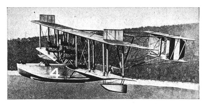
Die amerikanische Marine entwickelte im Jahre 1919 für Atlantikversuche das Flugboot Curtiss NC-4. Es gelang einer solchen Maschine, mit Zwischenlandungen von Rockaway via Neufundland und Azoren nach Lissabon zu fliegen.
