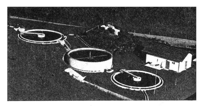
Kläranlage Obfelden, Kt. Zürich, mit Rechen und Sandfang (ganz links), Vorklärbecken (links vorne), Tropfkörper (Mitte), Nachklärbecken (rechts), Faulraum (im Hintergrund links), Maschinenhaus, Trockenbeet (hinten rechts noch knapp sichtbar), Ablaufkanal und Bach (vorne ganz rechts).
