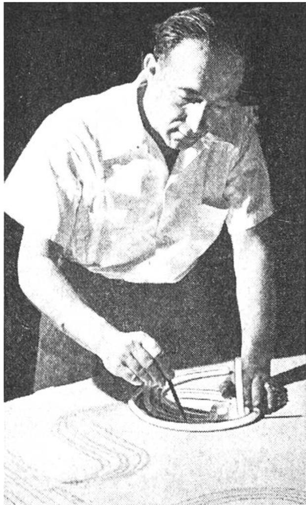
Die endgültige Form der Neonröhren wird vorerst auf Asbestplatten aufgezeichnet, damit die erhitzten Glasmassen genau nach Muster gebogen werden können.
