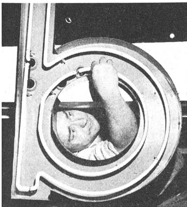
Die fertiggestellten Neonröhren werden meistens auf einer Metallunterlage von gleicher Form befestigt, die auch am Tag als Reklame dient, wie auf unserem Bild der Buchstabe b, der mit anderen zu einer Schrift zusammengestellt wird.
