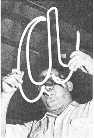
Die endgültige Form der Neonröhren wird vorerst auf Asbestplatten aufgezeichnet, damit die erhitzten Glasröhren genau nach Muster gebogen werden können.
