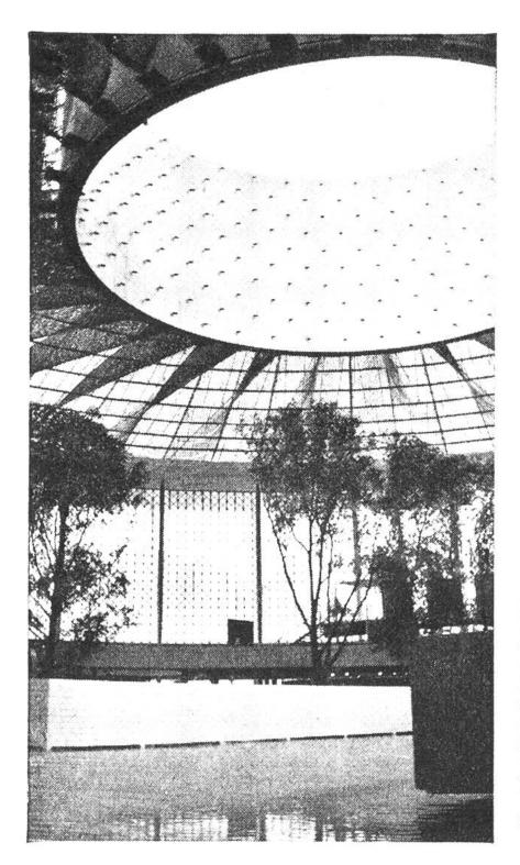
Das Dach des USA-Pavillons gleicht mit dem an Metallkabeln aufgehängten Metallreifen einem waagrecht liegenden Velorad. Unter der Öffnung ist ein See mit kleinen Inseln, auf denen 10 alte, ca. 15 m hohe und während des Baus sorgfältig geschützte Weidenbäume stehen.
