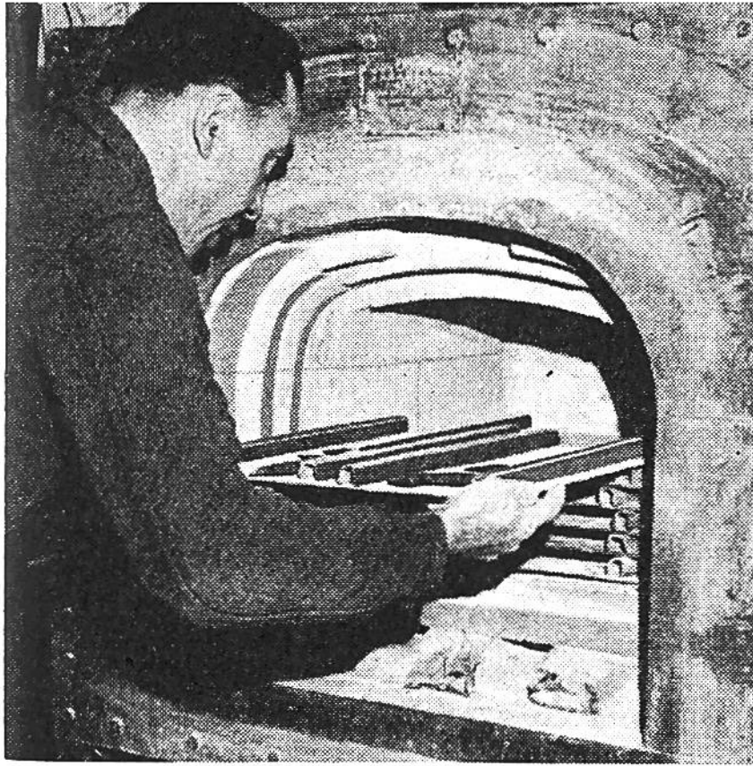
Der Brennofen, der einem Töpferofen gleicht. Hier werden die bemalten Gläser gebrannt.
