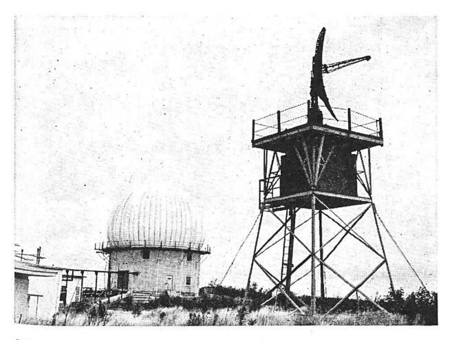
Die rotierende Antenne der Radarstation bei Charleston in den Vereinigten Staaten ist auf dem Gerüstturm rechts vorn aufgestellt. Die empfindlichen Instrumente, mit denen weit entfernte Flugzeuge festgestellt und ständig beobachtet werden, sind in einem kugelförmigen Zelt aus gummiertem Nylonstoff untergebracht, das in diesem Fall auf einem Unterbau aus Wellblech steht.
