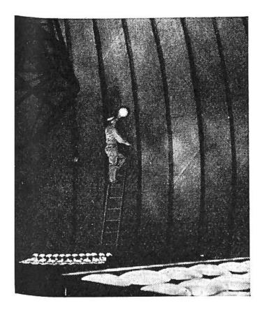
Blick ins Innere des mit Druckluft aufgeblasenen Nylonzeltes.
