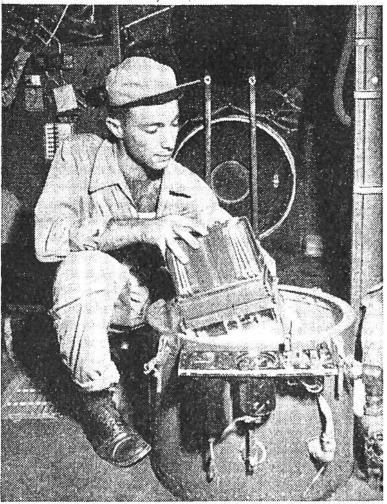
Die Radiosonde, welche die Wetterelemente ermitteln soll, wird zum Start bereitgemacht, ehe sie durch die Bodenöffnung in den Wirbelsturm hinabgelassen wird.
