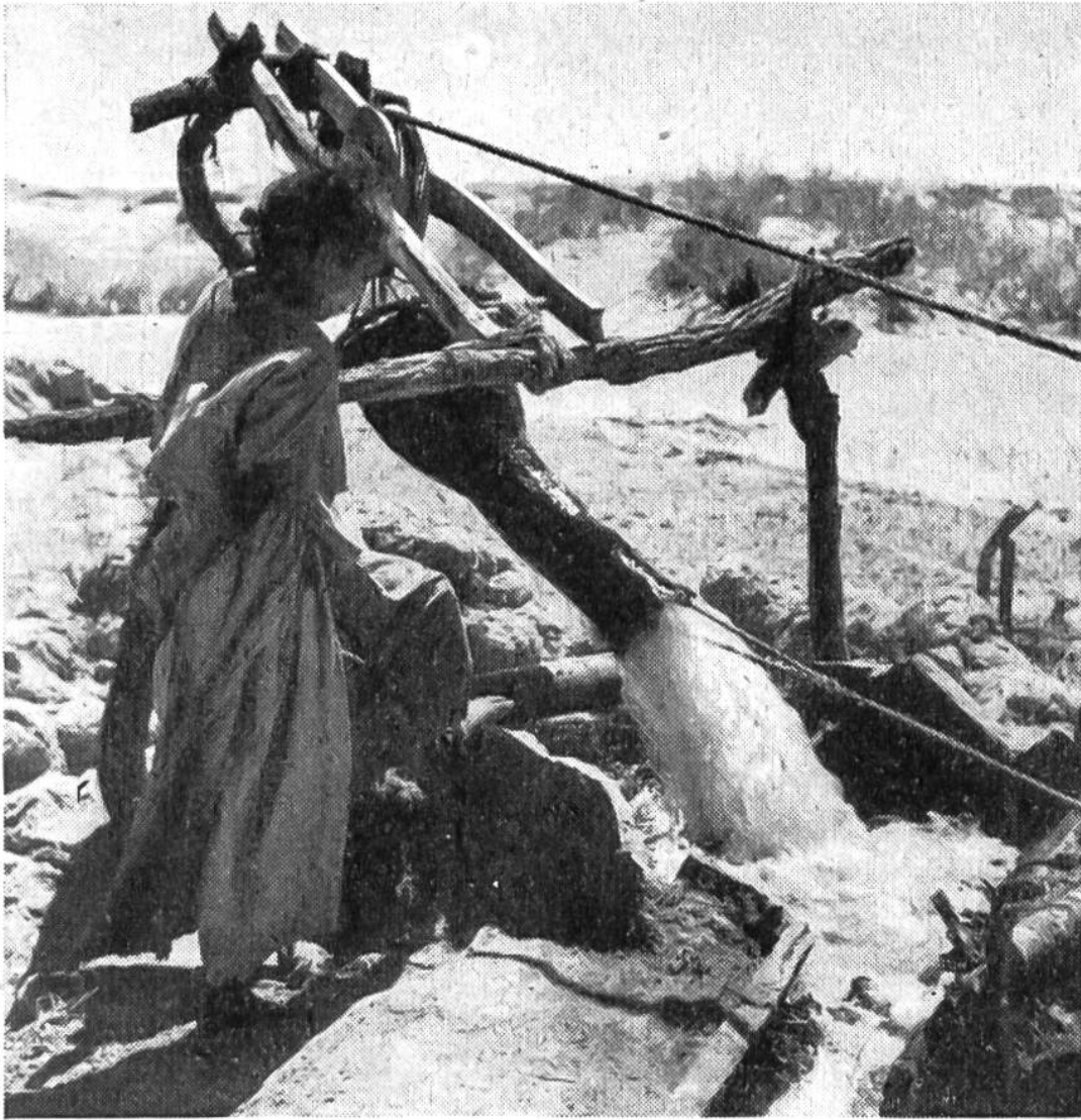
Ein Schöpfbrunnen in Betrieb. Der Schlauch entleert das Wasser in eine Leitung, durch welche die Felder bewässert werden.
