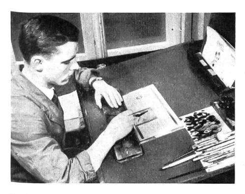
Deckarbeit auf dem Rasterklischee zur Korrektur der Tonwerte.
