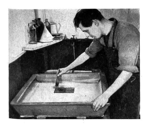
Das Ätzen kann beginnen. In der Säureschale (Bild oben) oder Ätzmaschine werden die blanken Metallteile (das sind die nicht druckenden) tiefgeätzt, während die durch das Schellackhäutchen geschützten Bildteile stehenbleiben. Da die Salpetersäure aber auch seitwärts ätzt, die Bildteile also unterhöhlen würde,
