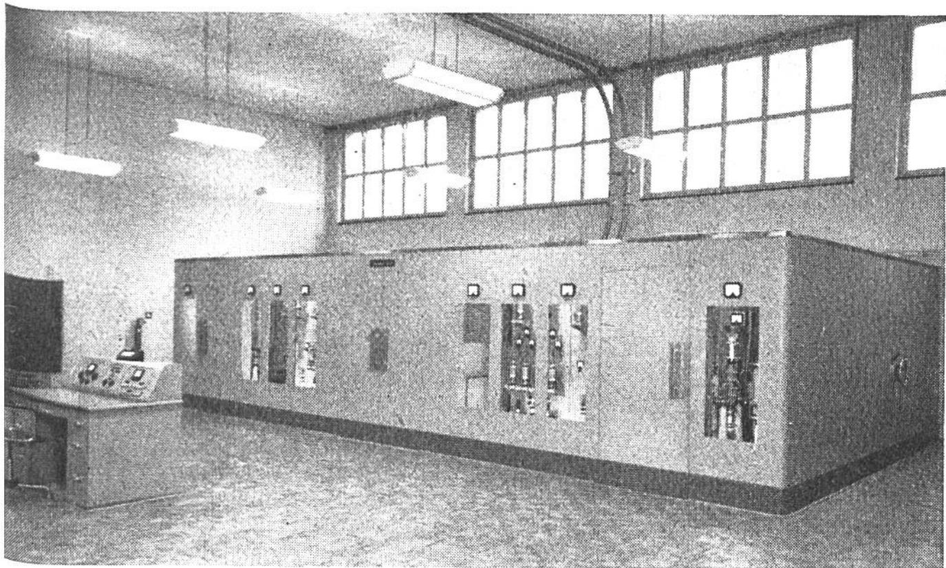
Im Sendesaal der Rundspruchstation Sottens befinden sich zwei 100-kW-Sender, die miteinander gekoppelt werden können. Die unter Hochspannung stehenden, empfindlichen Apparate und Senderöhren sind in stählernen Kabinen geschützt aufgestellt und können während der Sendung nur durch die Fenster beobachtet werden. Vom Kommandopult aus werden alle Apparaturen eingeschaltet und überwacht.
